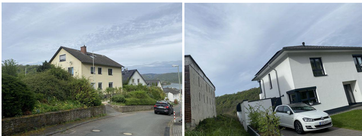
Abb.: Bauungen im Geltungsbereich mit geneigten Dächern (eigene Aufnahme, 04.2024)
