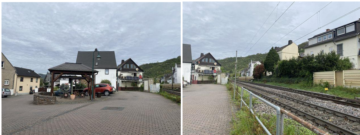
Abb.: Blick auf den Platz (links) und die Bahnstrecke (rechts) (eigene Aufnahme, 04.2024)
