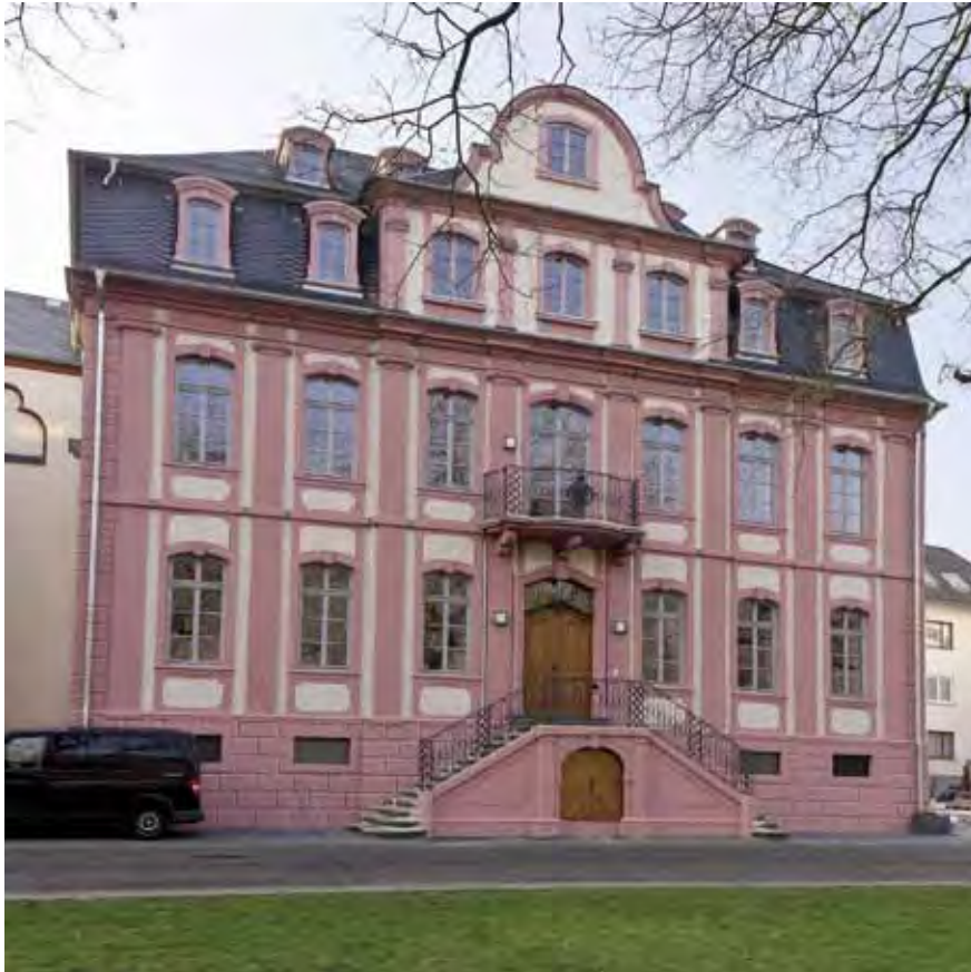
Wiederherstellung der historischen Farbgebung des Knoodt'schen Hauses in Boppard
