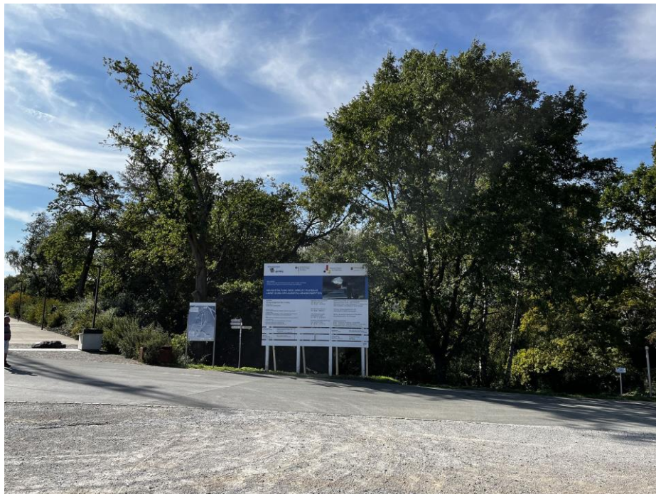
Abb.: Blick auf den Ordnungsbereich 5 des Multifunktionsgebäudes (eigene Aufnahme)
