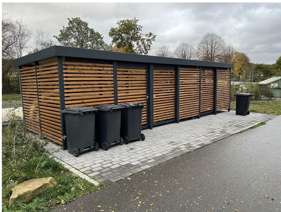
Abb.: Blick auf den Mülltonnensammelplatz (eigene Aufnahme)
